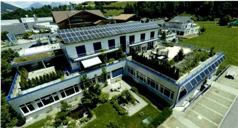
Firmensitz der elektroplan Buchs & Grossen AG: Mit intelligenter Gebäudeautomation reagieren Licht und Storen auf die Präsenz der Mitarbeitenden.
