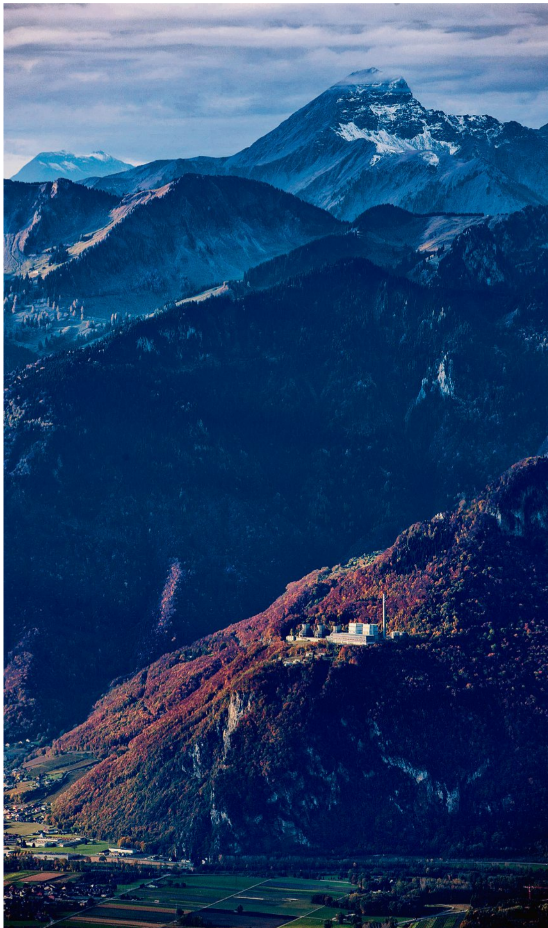
Das Ölkraftwerk Chavalon im Kanton Wallis sollte zum Gaskraftwerk umgebaut werden. Foto: Keystone
