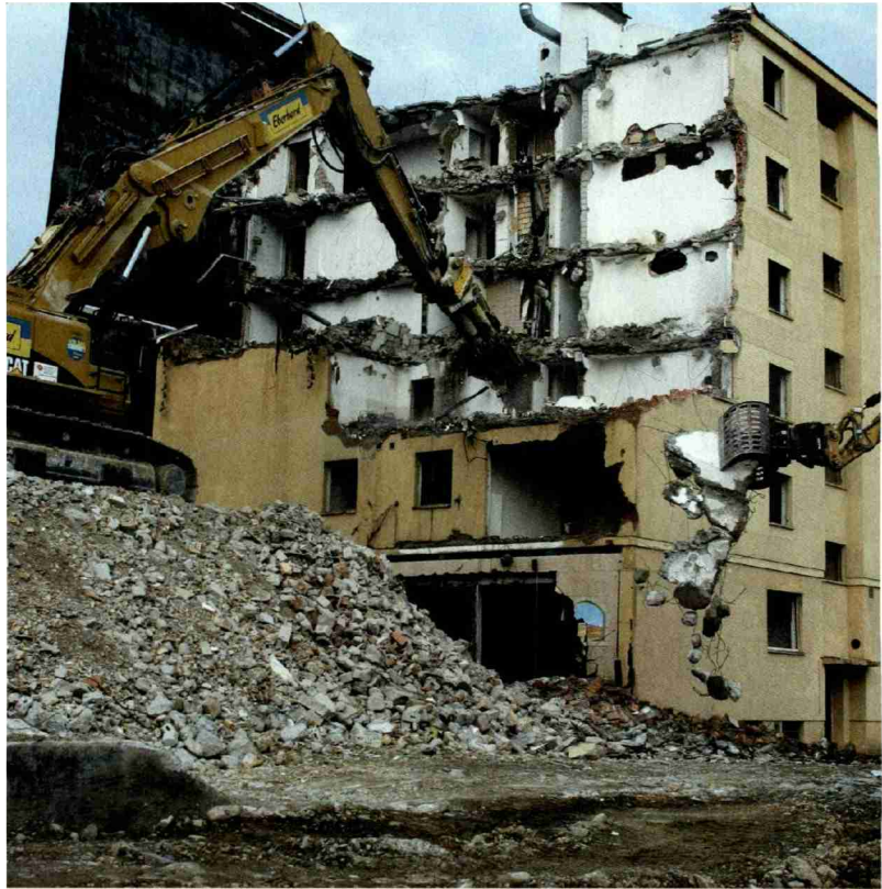
Wenn Gebäude das Nutzungsende erreicht haben, können sie als eine Art Rohstofflager für die Produktion von Beton dienen. (Bild: Abriss eines Gebäudes an der Wehntalerstrasse in Zürich)
