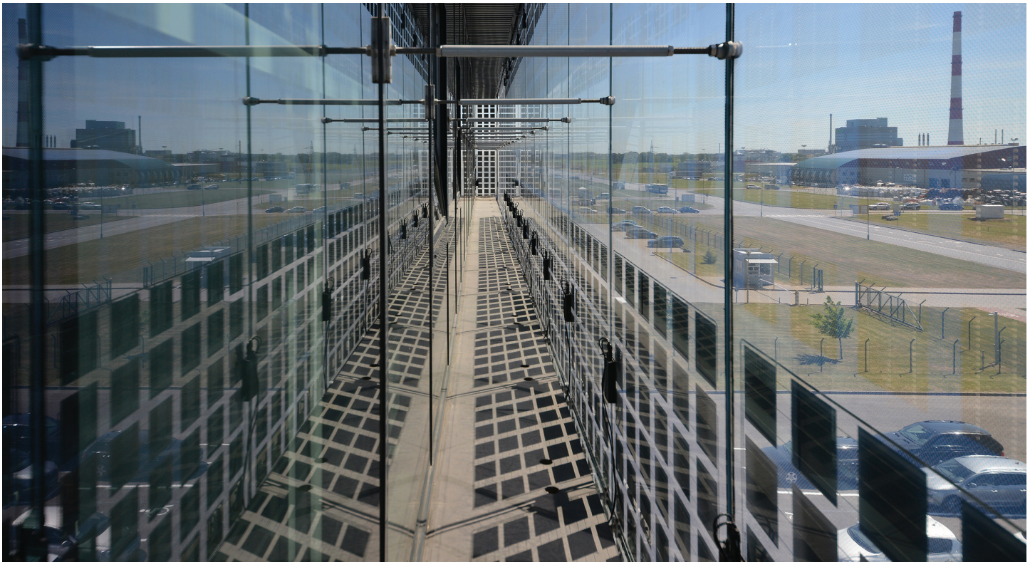
PV-Module können auch auf Glasfassaden eingesetzt werden, ohne die Transparenz wesentlich zu vermindern. Auf dem Foto: Double-skin-Fassade mit kristalliner Solarzelle in Klaipeda (Litauen). Die Glasmodule schützen das Gebäude vor Überhitzung und Windlast. Foto: Frontini
