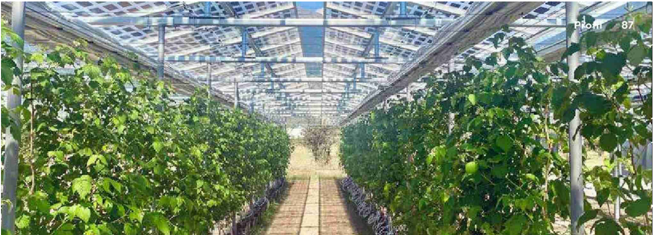
Beispiel von Agri-Photovoltaik über Himbeeren mit semitransparenten PV-Modulen (Quelle: Insolight SA).
